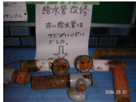
給水管の取替工事
