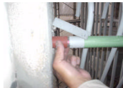
(新しくパイプを継ぎ足し周囲にコーキング代を作る)
